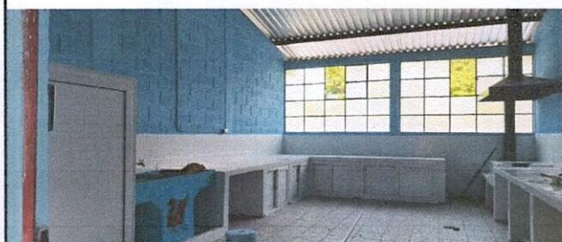
Foto 2: SUSTITUCIÓN Y REPARACIÓN DE AREA DE COCINA
