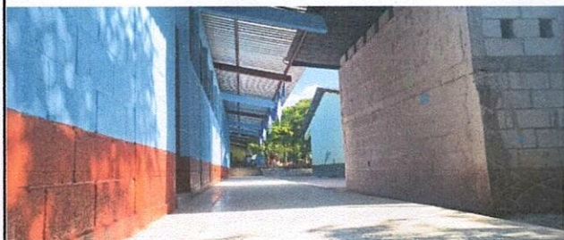
Foto 1: SUSTITUCIÓN DE PISO
