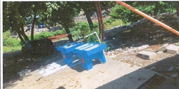
Foto 4: CAMBIO DE TUBERIA DEL ESTABLECIMIENTO Y LAVADO DE MANOS
