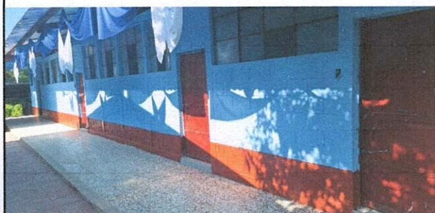
Foto 3: PINTURA DE MURO INTERIOR Y EXTERIOR
